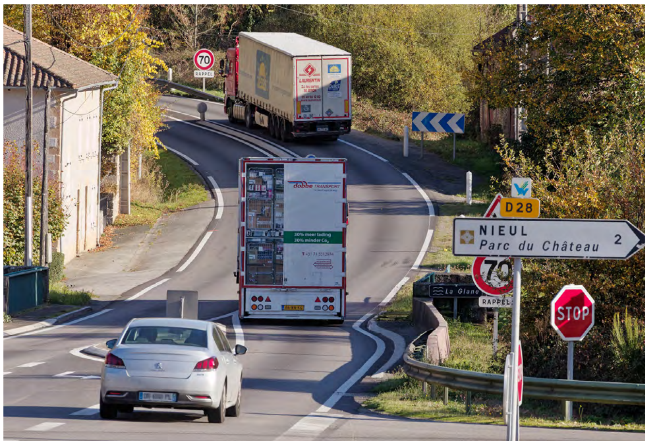
Traversée de la Glane à Nieul
